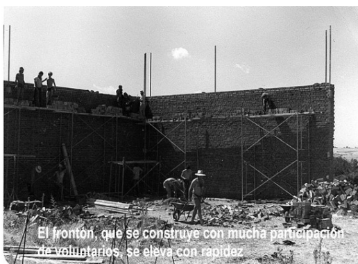
Foto: Construcción del Frontón (Peñablanca)
